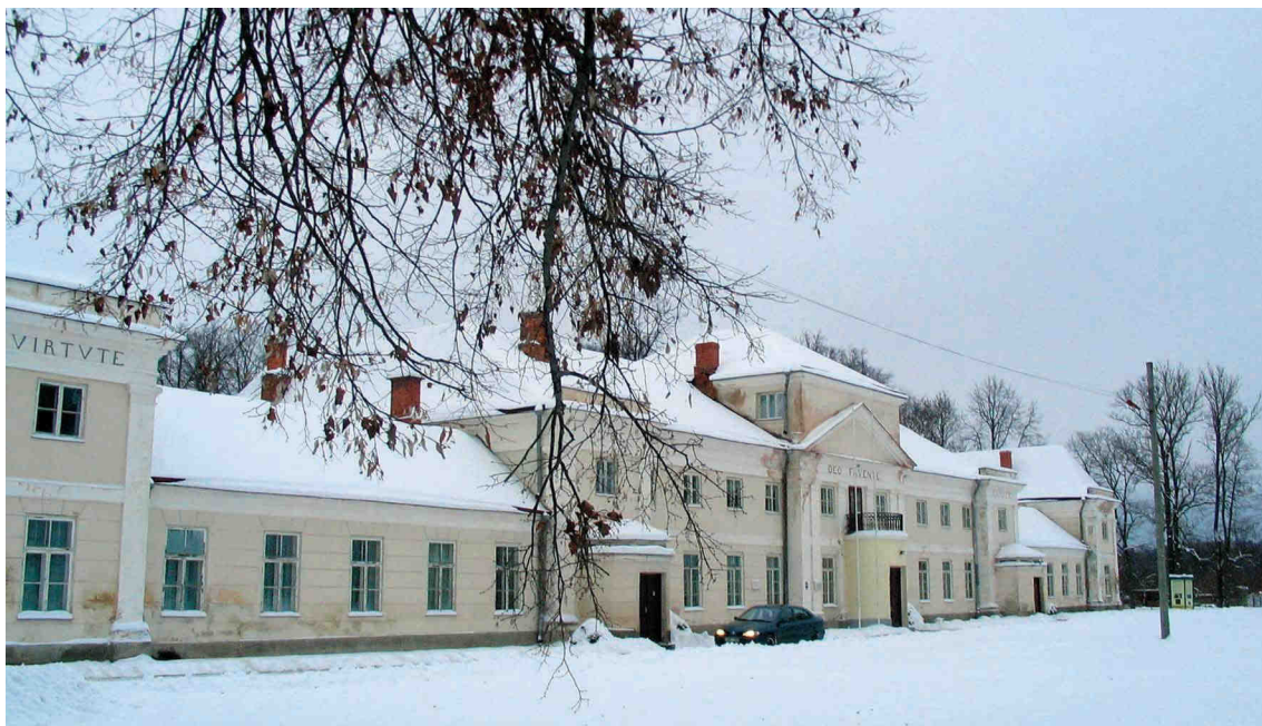
16. Warklany, pałac, elewacja frontowa. Fot. J. Polanowska, 2010 r.
