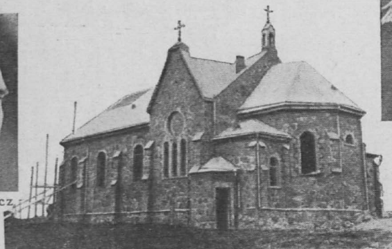
Widok budującego się kościoła w Rudziszkach.
