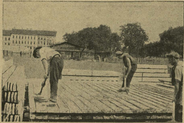
Obraz 13. Betonowanie górnych części przekroju.
