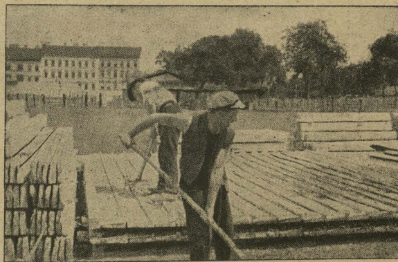
Obraz 11. Wlewanie masy betonowej do połowy przekroju.
